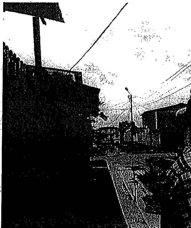
Foto 3. Red de tendido eléctrico existente en el predio.
