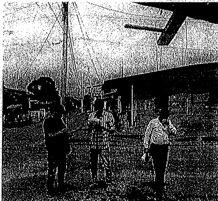
Foto 4. Toma de coordenadas – Tendido eléctrico.
